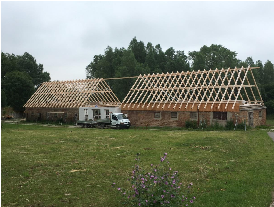
Ausbau Scheune auf dem Gut Frankenthal zum Vereinshaus
